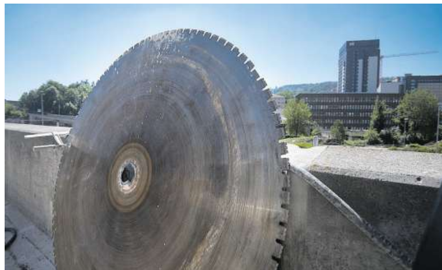
Ein grosses Schneideblatt entfernt die Krone der Stützmauer.
