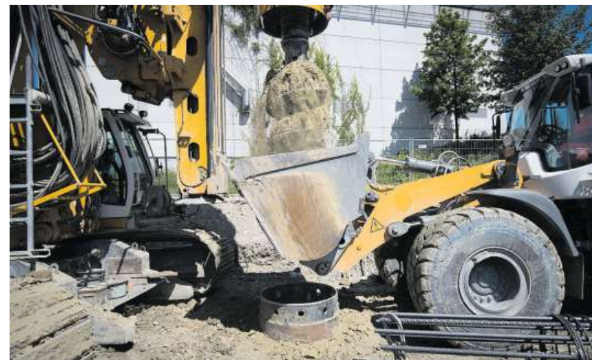
Eine Baggerschaufel nimmt die Erde aus den Bohrlöchern auf.
